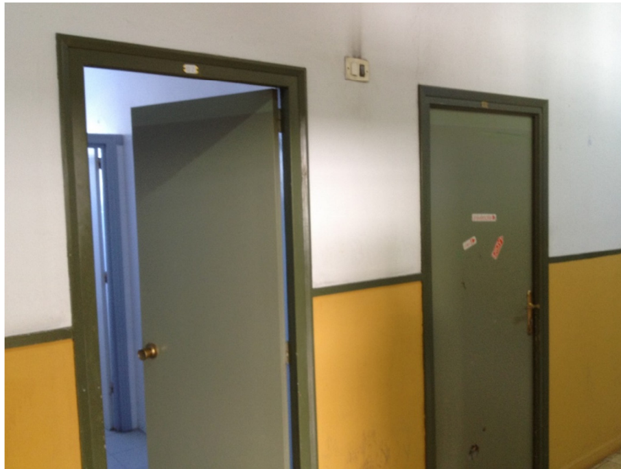
IMAGEN 11. Falta de señalización y accesibilidad en servicios higiénicos
